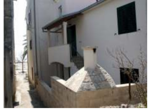
Nouvelle construction appartement 3
